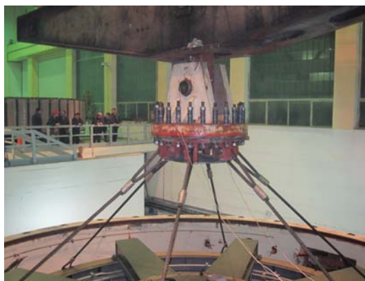
Slika 11. Pripravak povezan sa statorom i dizalicama.
